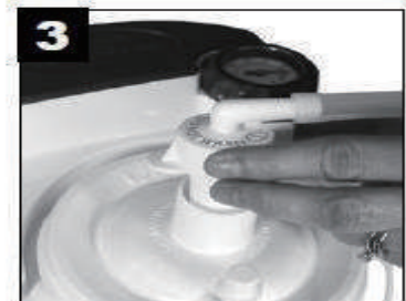
安裝新的過濾器 and 連接短管。
